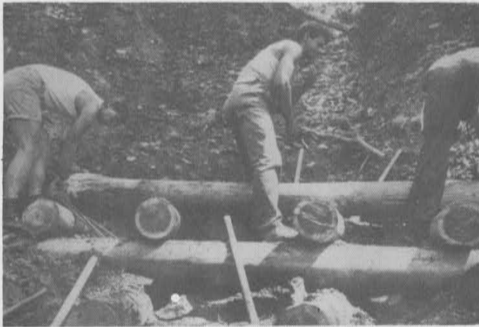
Der Bau des Holzkastens erforderte besondere fachliche Qualifikation und war harte Arbeit.
