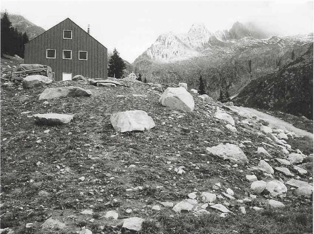
Der Neubau liegt oberhalb Fuorns auf 1850 Metern. (Bild: Nicolas Contesse)
